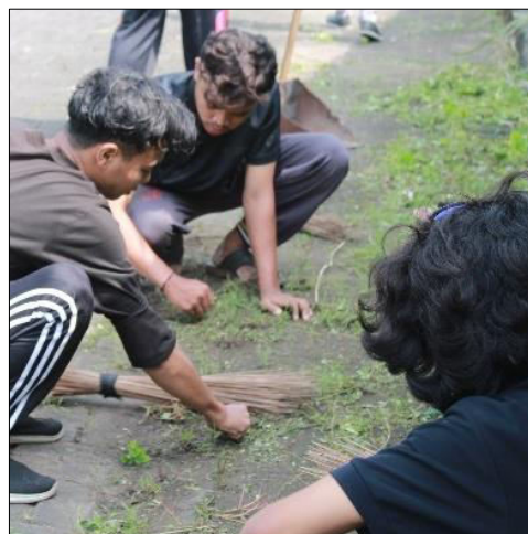
Gambar 3. Proses Penyabutan Rumput di Jalan Kiyai Haji Bisri Syansuri.
